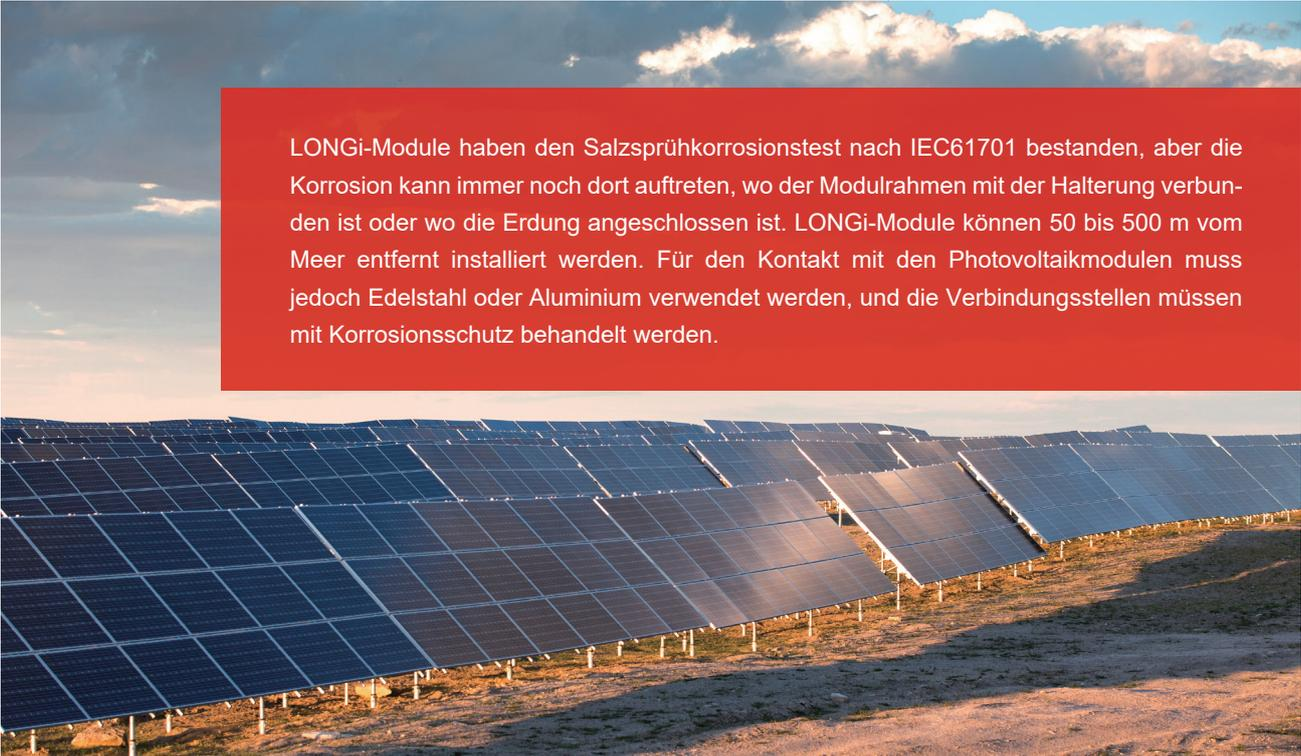
LONGi-Module haben den Salzsprühkorrosionstest nach IEC61701 bestanden, aber die Korrosion kann immer noch dort auftreten, wo der Modulrahmen mit der Halterung verbunden ist oder wo die Erdung angeschlossen ist. LONGi-Module können 50 bis 500 m vom Meer entfernt installiert werden. Für den Kontakt mit den Photovoltaikmodulen muss jedoch Edelstahl oder Aluminium verwendet werden, und die Verbindungsstellen müssen mit Korrosionsschutz behandelt werden.
