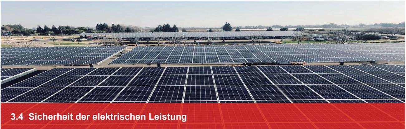
PV-Module können unter Beleuchtung Gleichstrom erzeugen. Jeder Kontakt des freiliegenden Metalls der Modulverbindungsdrähte kann zu Stromschlägen oder Verbrennungen führen. Jeder Kontakt mit 30 V oder mehr Gleichspannung kann tödlich sein.
